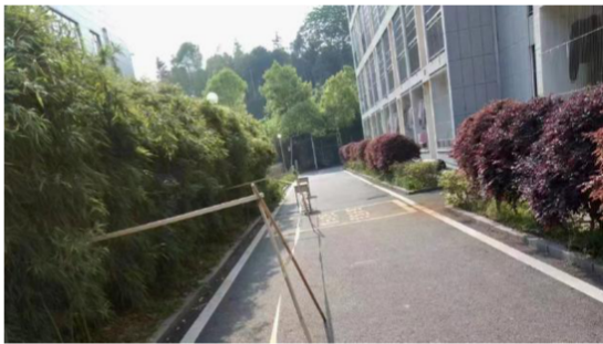
图 6-1 围墙改造前照片
